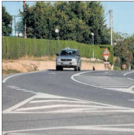
Els treballs tenen lloc a la urbanització Blancafort.
