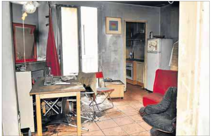
Así quedó el interior del piso de Rosa tras el incendio en el que falleció, en la calle Santa Anna. FOTO: A. GONZÁLEZ
