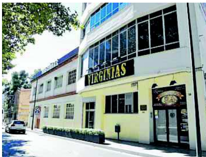
Instalaciones de Virginias en el Passeig Sunyer de Reus.
